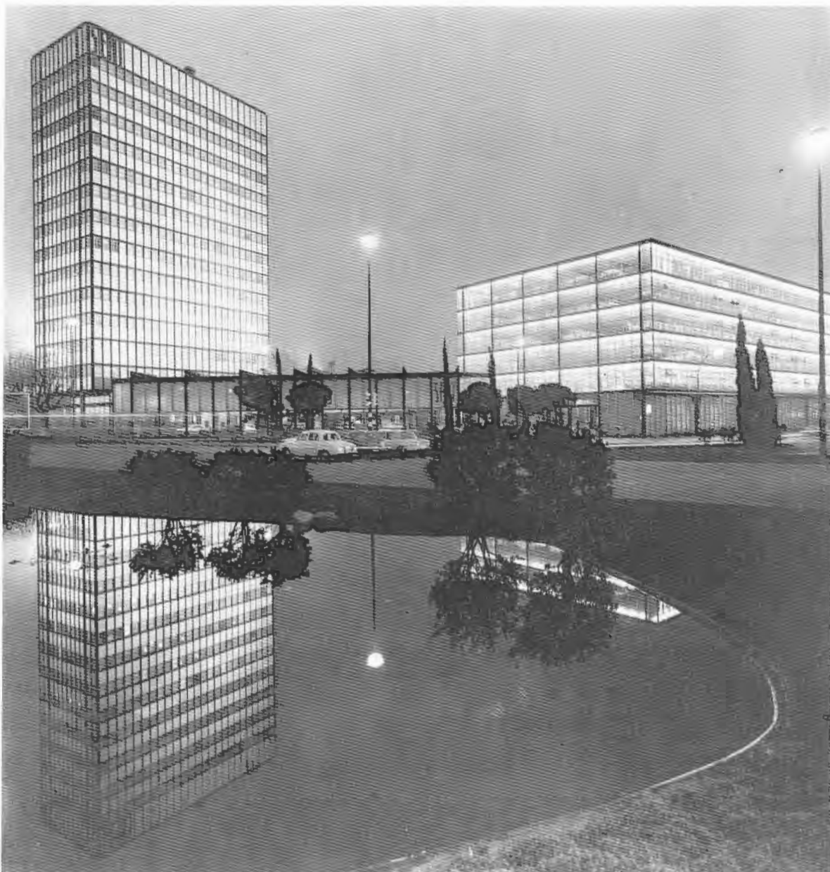
El Centro de Gestión Catastral y Cooperación Tributaria tiene en sus manos la responsabilidad de determinar a ciencia cierta si es técnicamente posible disponer en este país de un sistema de valoración eficaz. (Edificio SEAT. Barcelona. 1958.)
